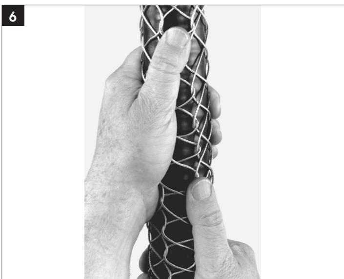
**7** Acople el cable de elevación a la manga como se muestra en la Figura 7. Ate la bajada del cable o de la guía de ondas al cable de elevación de modo que la bajada no se balancee. Tense lentamente el cable de elevación para que la manga de izar quede apretada por igual sobre el cable o la guía de ondas.
